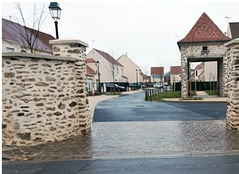
Le mur en pierre et le pigeonnier réhabilités
